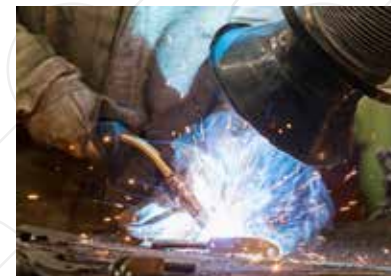
Lokální odsávání svařovacích pracovišť
