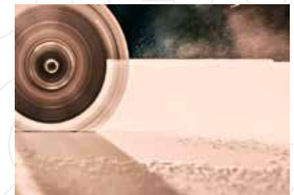
Lokálne odsávanie pracovísk rezania materiálov
